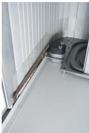
Закрепить ленту стопорного механизма на алюминиевом завершающем профиле (саморезом)
